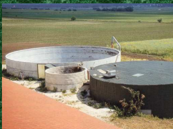
Typowy reaktor wykorzystujący płynne odchody zwierzęce.
